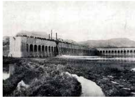
写真-4 立神係船池（T5 竣工）
