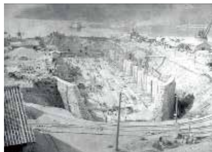
写真-1 佐世保工廠第一船渠
