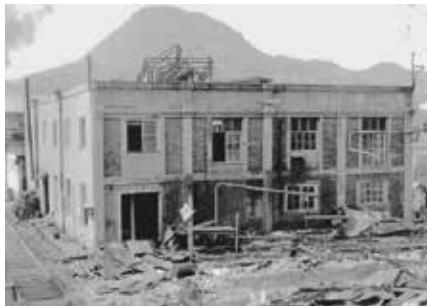
写真-2 第一烹炊所（M38.9 竣工）
