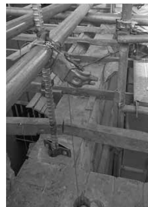
煉瓦壁へのステンレス筋挿入
