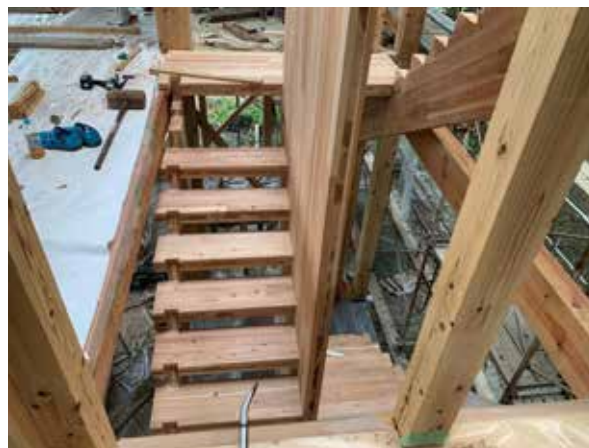
CLT材のみで構成される階段
