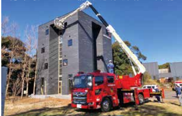
完了検査時に消防避難訓練を実施
