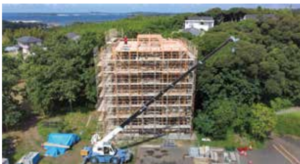
4階建て方完了時の全景写真
