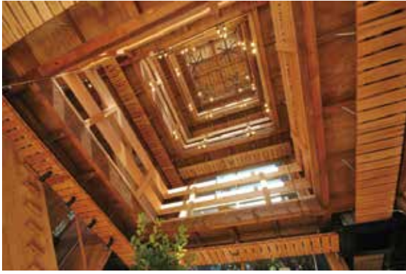
完成した4層吹き抜け、総製材あらかしの空間
