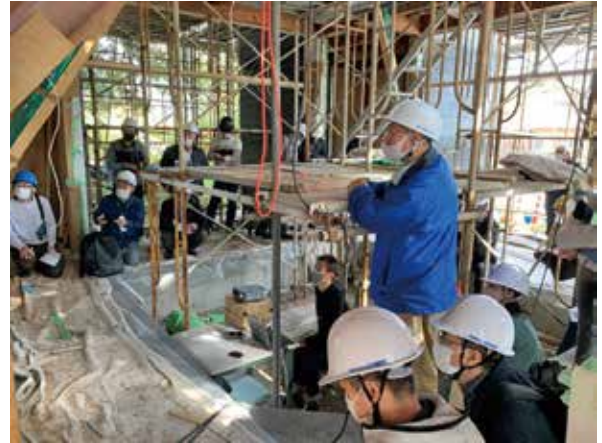
11.20 現場施工見学会：午前・午後の部に約80名参加
