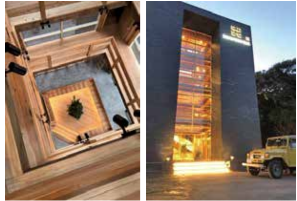
令和5年1月30日 竣工写真
